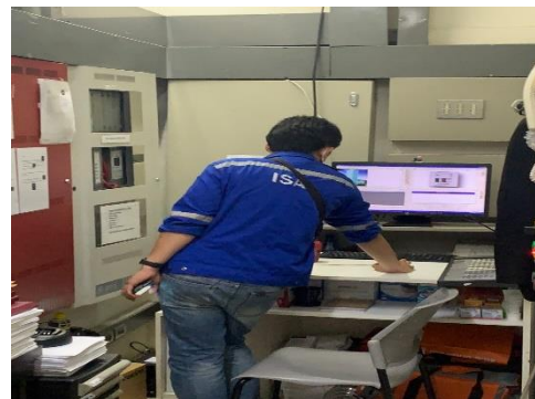
ภาพที่ 2.2-17 เจ้าหน้าที่ตรวจสอบระบบป้องกันและแจ้งเตือนอัคคีภัย
