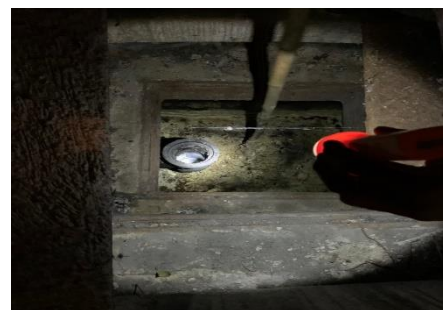
ภาพที่ 2.2-5 สูบไขมันจากบ่อดักไขมัน
